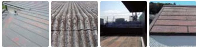
トタン スレート コンクリート床 コロニアル
