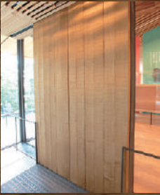
エントランスの自動扉には五寸釘ではつた名栗板を使用。絶妙なはつり加減は圧巻!
